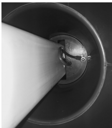
图13 双屏蔽套管高压引线典型接线
